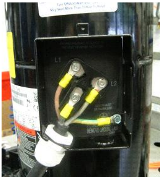
Рис. 20: Правильное электрическое подключение клеммной коробки IP21 с помощью кабельной муфты (компрессоры ZBD30K* - ZBD114K* / ZFD13KVE - ZFD25KVE / ZFD41K5E)
